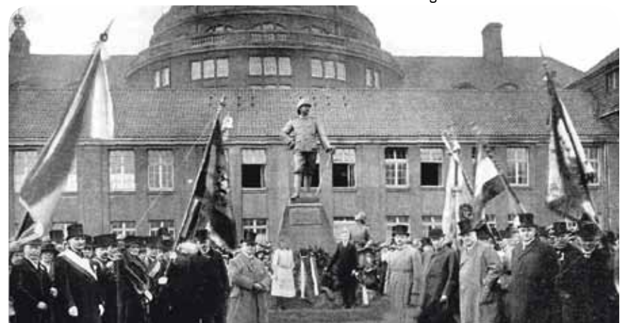
noch steht das Denkmal
