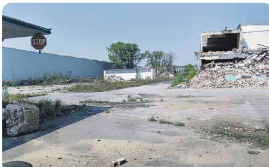
Die ersten Bäume wurden schon gefällt - ohne Genehmigung
